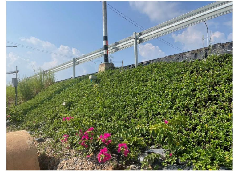
ภาพที่ 38 รูปภาพการก่อสร้างแล้วเสร็จเป็นระยะเวลา 3 เดือน รูปแบบที่ 2 CAPILARY BARRIER SYSTEM
